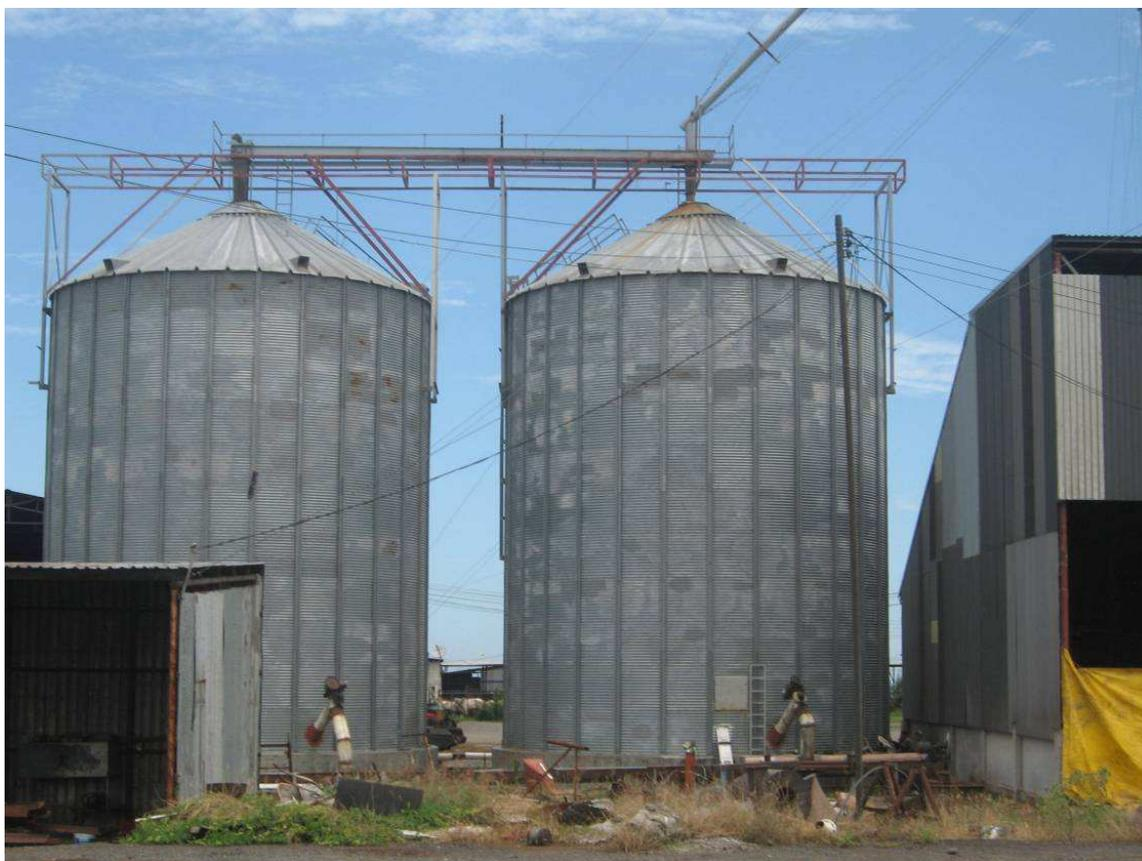
Figura 17. Silos con capacidad para 10Toneladas, para almacenar maíz entero.
